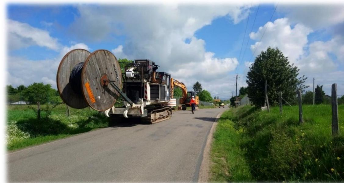
Exemple de chantier d'enfouissement de câble le long d'une voirie (source : scieppd)
